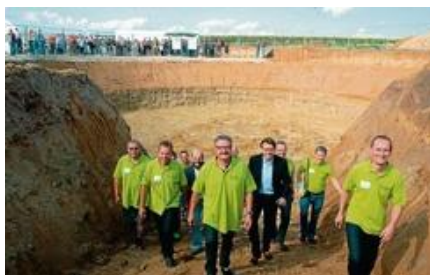
Die Energiegenossen auf dem Weg aus der Baugrube.
