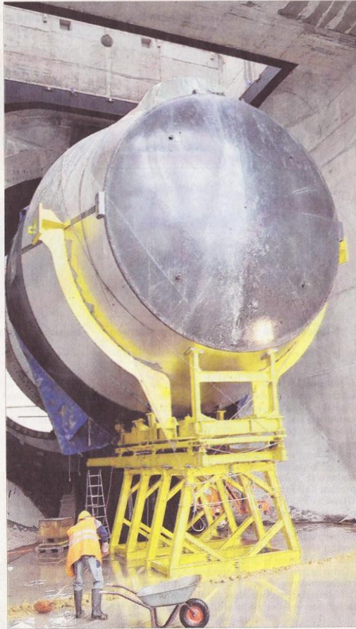
Wasserkraft ist regenerativer Energielieferant Nummer eins im Südwesten. Hier wird an der Turbinenkammer im Kraftwerk Rheinfelden gebaut. Archivfotos
